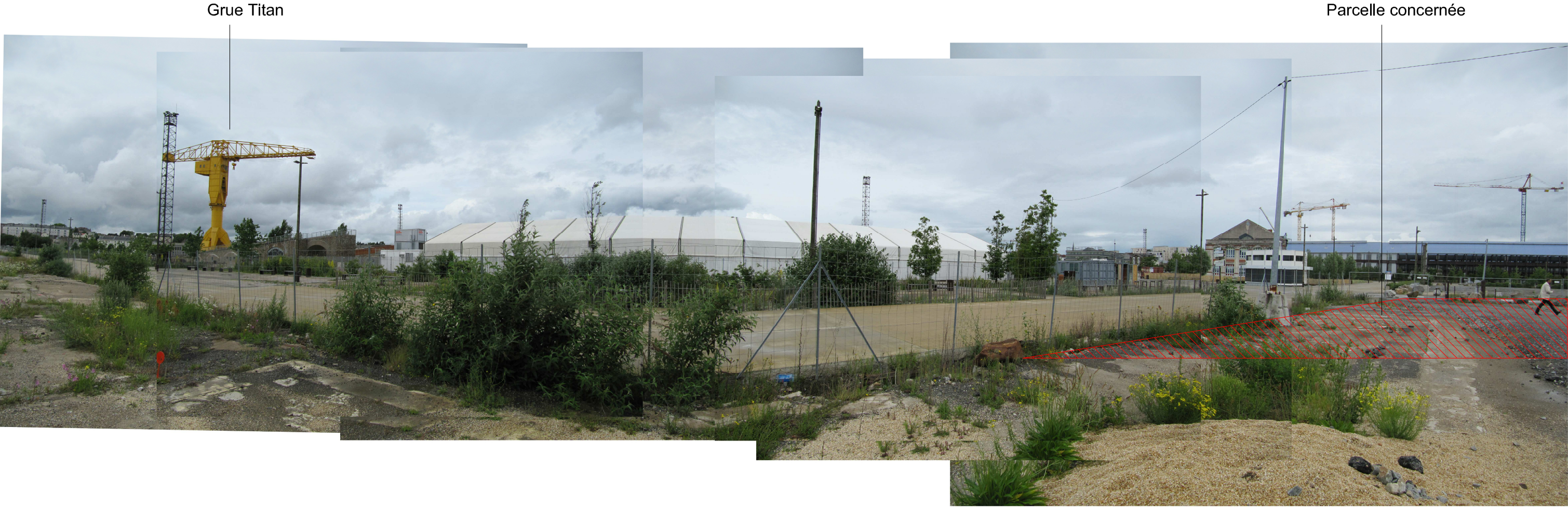
VUE COTE PRAIRIE AU DUC, VERS LE NORD (voir repérage sur plan de situation)
